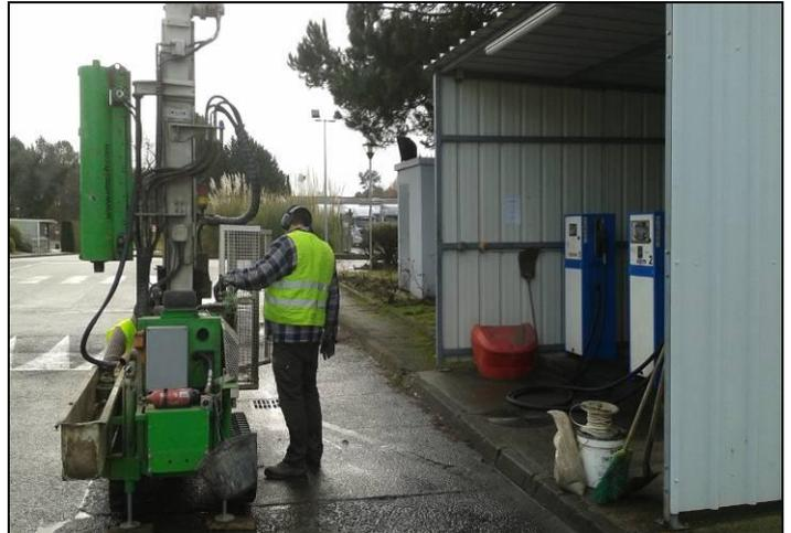
Les postes de distribution sont équipés au sol d'une dalle en béton afin d'imperméabiliser la zone.
