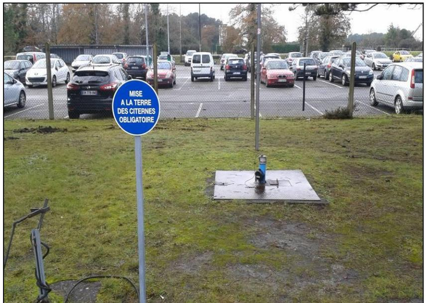
Il s'agit d'une cuve de gasoil d'un volume de 100 000 L et d'une cuve de GNR de 5 000 L. Les cuves sont équipées d'une double enveloppe, limitant la probabilité de fuite de carburant dans les sols.
